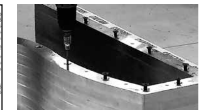
(c) ボルト締めの様子
